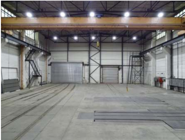
Teilfläche einer Lagerhalle mit Kran 12 t
