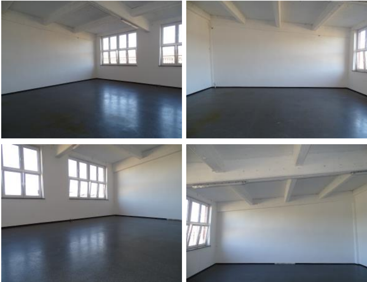
Lager 40 m 2 im sanierten Zustand
