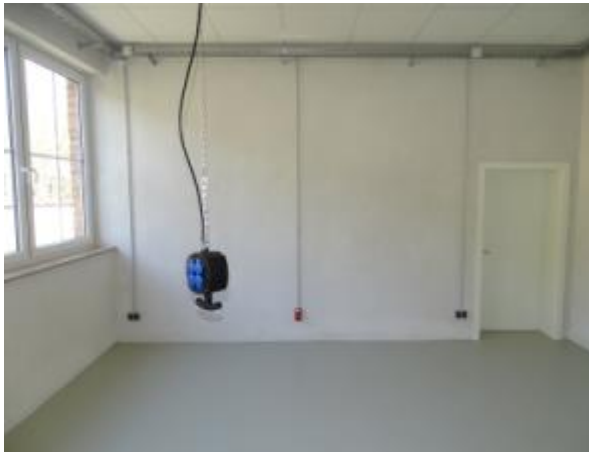
Beispiel Werkstatt im sanierten Zustand
